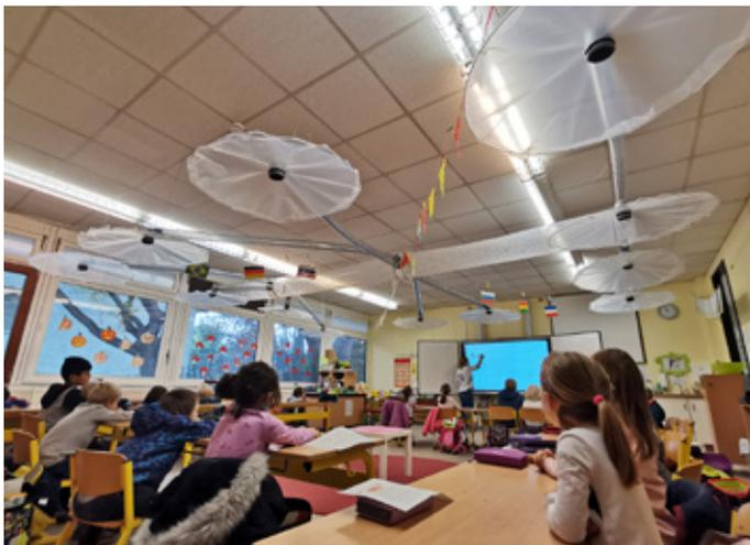
Frank Helleis hat eine Idee: Jeder Mensch produziert beim Atmen Aerosole, die potenziell Covid-Viren übertragen können. Diese Luft ist warm und steigt nach oben. Der Physiker entwirft eine Vorrichtung aus einfachen Elementen, die an der Decke montiert wird. Damit soll die ausgeatmete Luft nach draußen abgesaugt werden.
