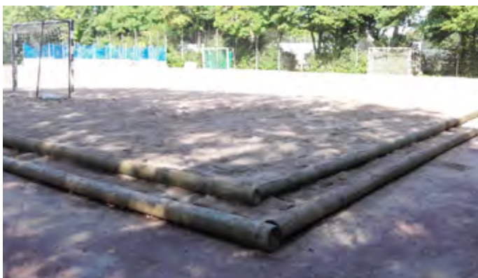
Der renovierte Beachplatz der TSG Bretzenheim
